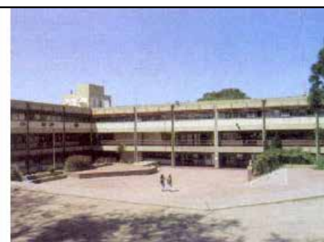
Figura 1: c) Vista actual desde las ventanillas del tercer piso donde se encuentra el área de investigación del Departamento de Química. Los edificios que rodean la plaza central corresponden a parte de la Facultad de Ciencias Exactas, Económicas e Ingeniería (a los costados) y los de frente a parte de la Facultad de Ciencias Humanas.
