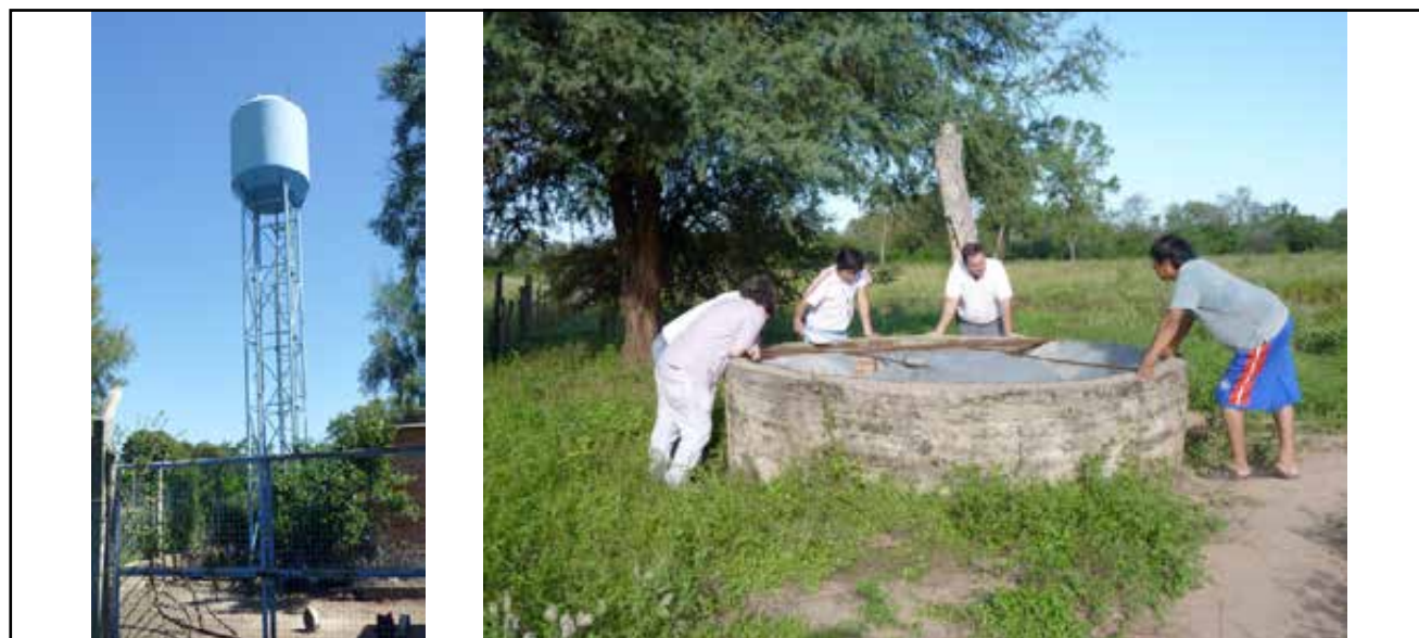
Figura 1: Sistemas de agua fuera de uso por falta de mantenimiento en parajes del norte argentino (marzo, 2014).
