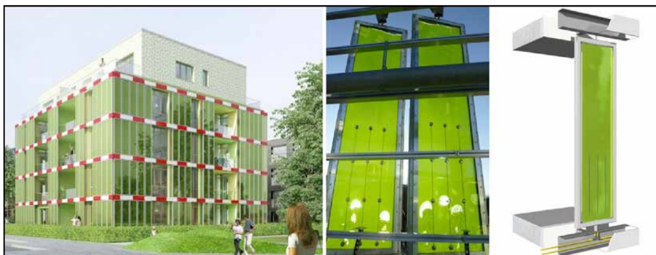
Figura 3: Primer edificio cuya energía se basa en microalgas (izquierda). Detalles de los fotorreactores de microalgas (derecha). Tomado de: http://phytoplanktonsource.com/worlds-first-algae-powered-in-germany/
