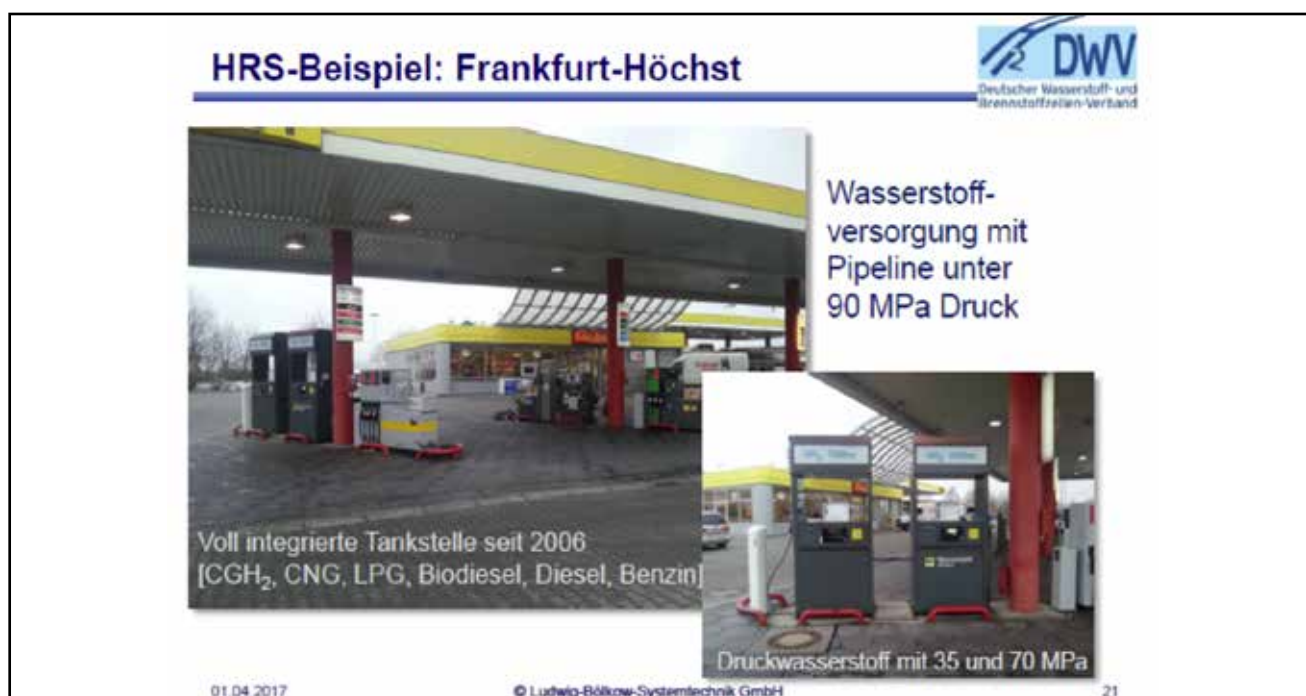
Figura 43: Estación de servicio, despacho multi-combustible, Frankfurt, Alemania - alimentación H2 por ducto.
