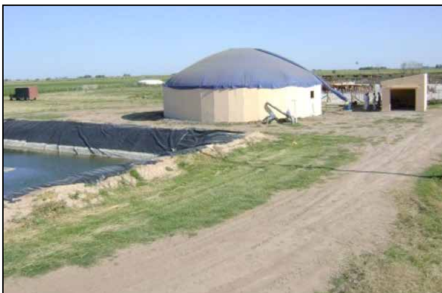
Ilustración 4. Vista de digestor y sala de control (derecha) y de laguna de digerido (izquierda).
