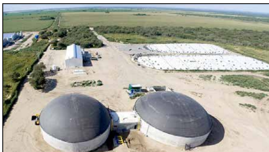
Ilustración 2. Silos de maíz planta entera (superior derecha), Sala de generación (superior izquierda), Digestores (inferior).
