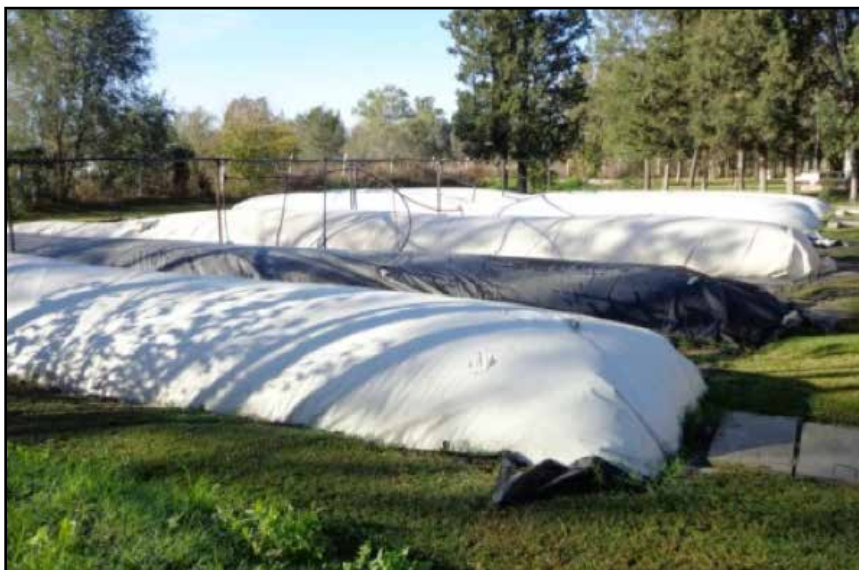
Ilustración 3. Vista de los digestores.
