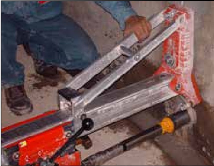
Figura 12. Extracción de testigos en una estructura de hormigón armado.
