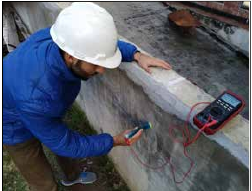
Figura 10. Medición del potencial de corrosión de las armaduras con un electrodo de referencia de cobre/sulfato de cobre saturado y un multímetro de alta impedancia.
