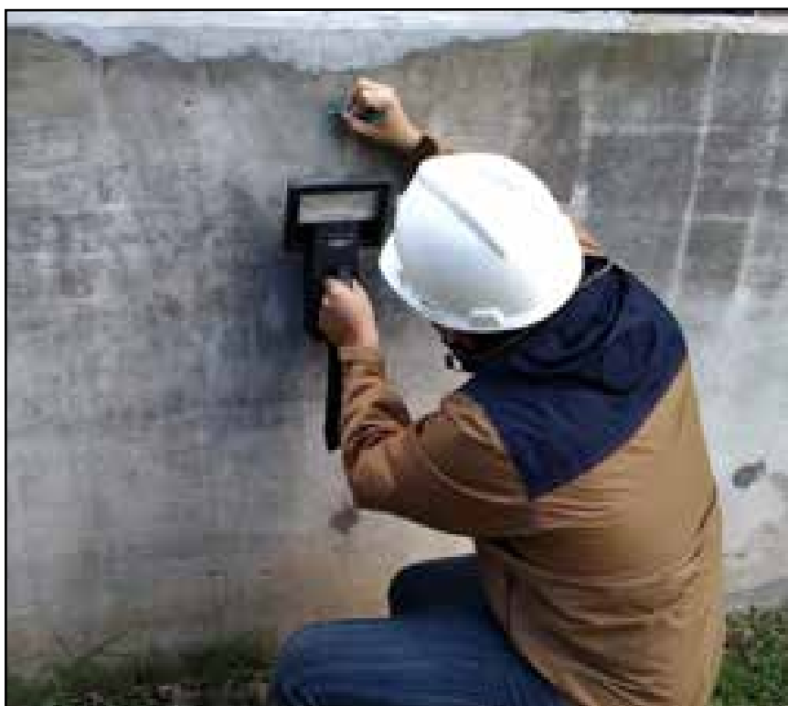
Figura 9. Localización de las armaduras por medio de un “pacómetro”.
