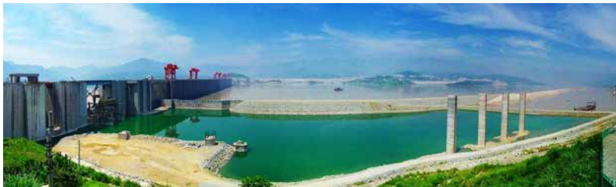
Figura 230. Visión panorámica del dique de Tres Gargantas en el río Yangtzé, China. Fuente: CC BY-SA 3.0, https://commons.wikimedia.org/w/index.php?curid=206094
