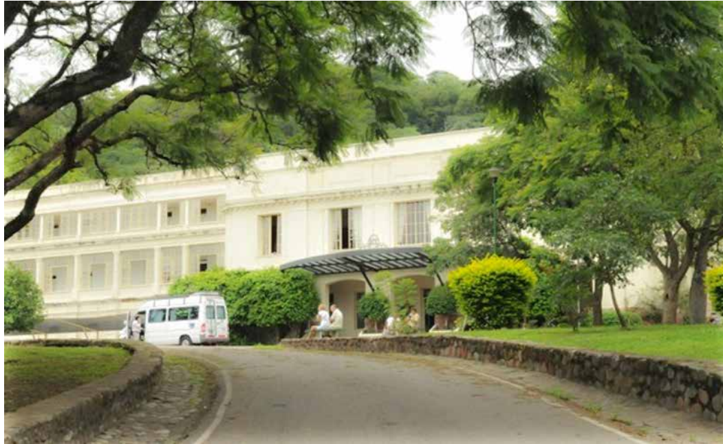
Figura 118. Vista actual del Hotel Termas de Rosario de la Frontera. Fuente: https://www.welcomeargentina.com/rosario-de-la-frontera/hotel-termas-rosario-frontera.html
