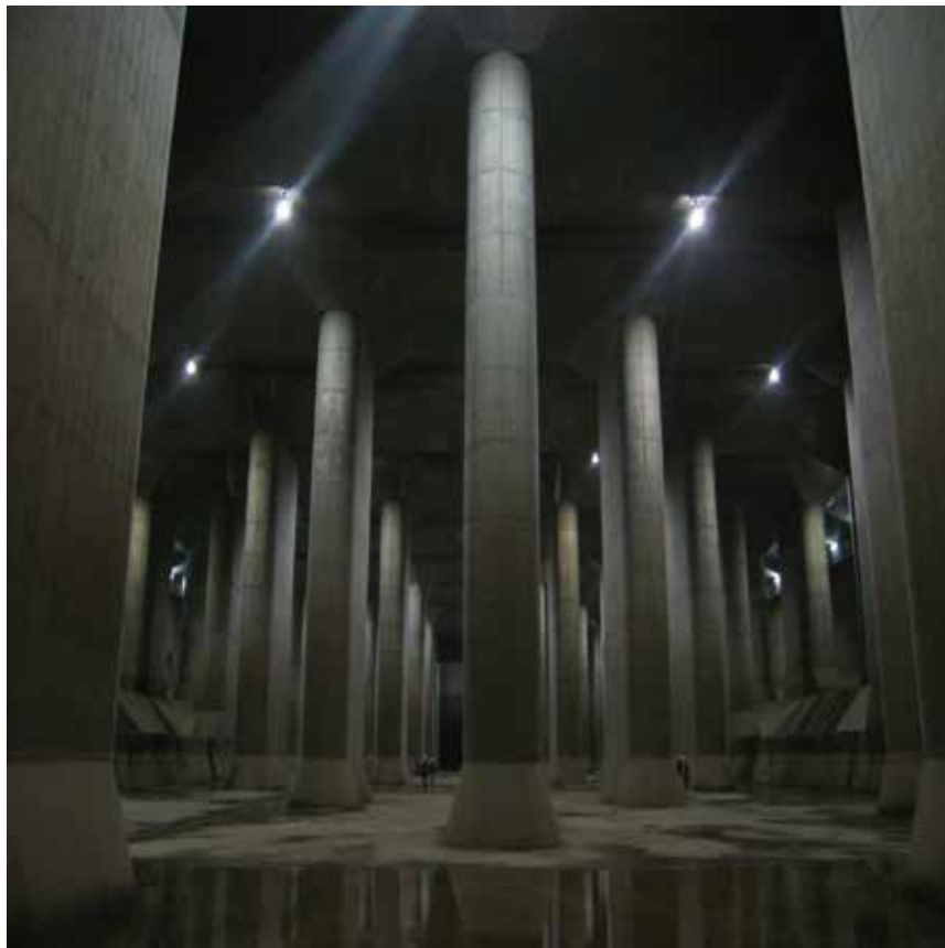
Figura 71. Vista de uno de los silos de hormigón del MAOUDC. Fuente: https://upload.wikimedia.org/wikipedia/commons/3/34/Kasukabe2006_06_07.JPG . Me hace recordar a los ambientes de los cuentos de H.P. Lovecraft.
