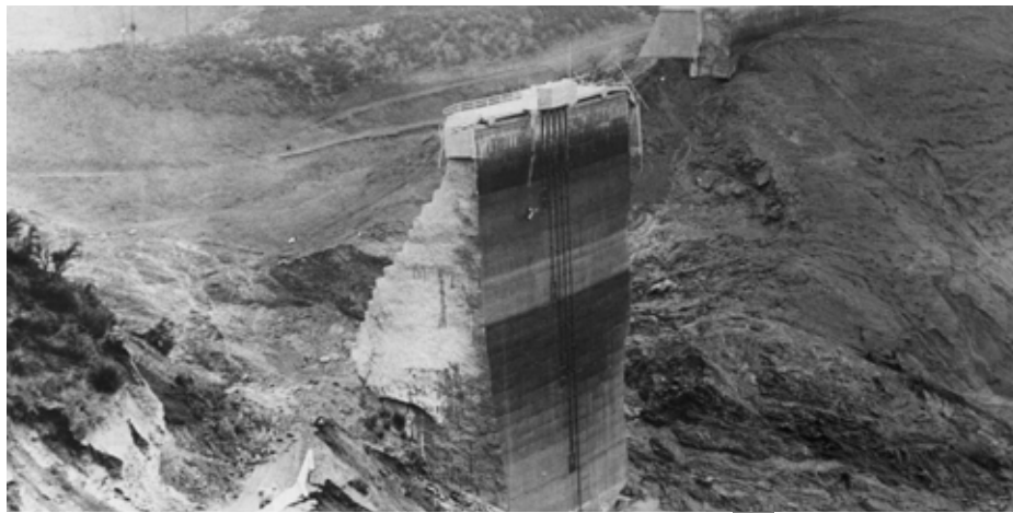
Figura 75. El dique St. Francis después de la rotura de sus laterales. Fuente: Newsweek, ver https://www.newsweek.com/st-francis-dam-disaster-los-angeles-warning-engineering-445915
