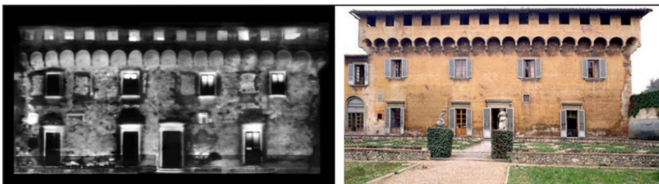
Figura 13: Termografía del frente de un edificio (izq.). Comparando con la imagen visual (der.), se obtiene evidencia de la ubicación de ventanas que fueron suprimidas<sup>7</sup>
