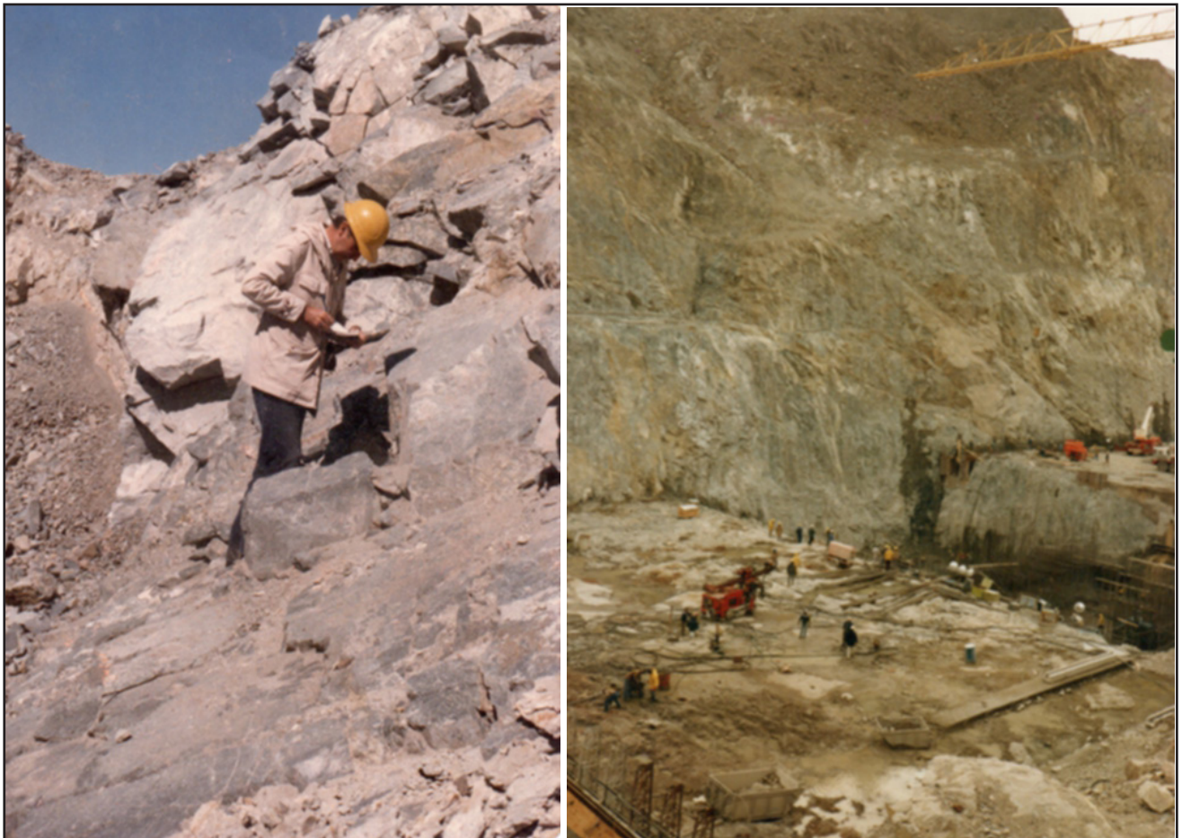
Figura 12: Haciendo mediciones durante los trabajos de excavación sobre el lecho del río Limay en Piedra del Águila.
