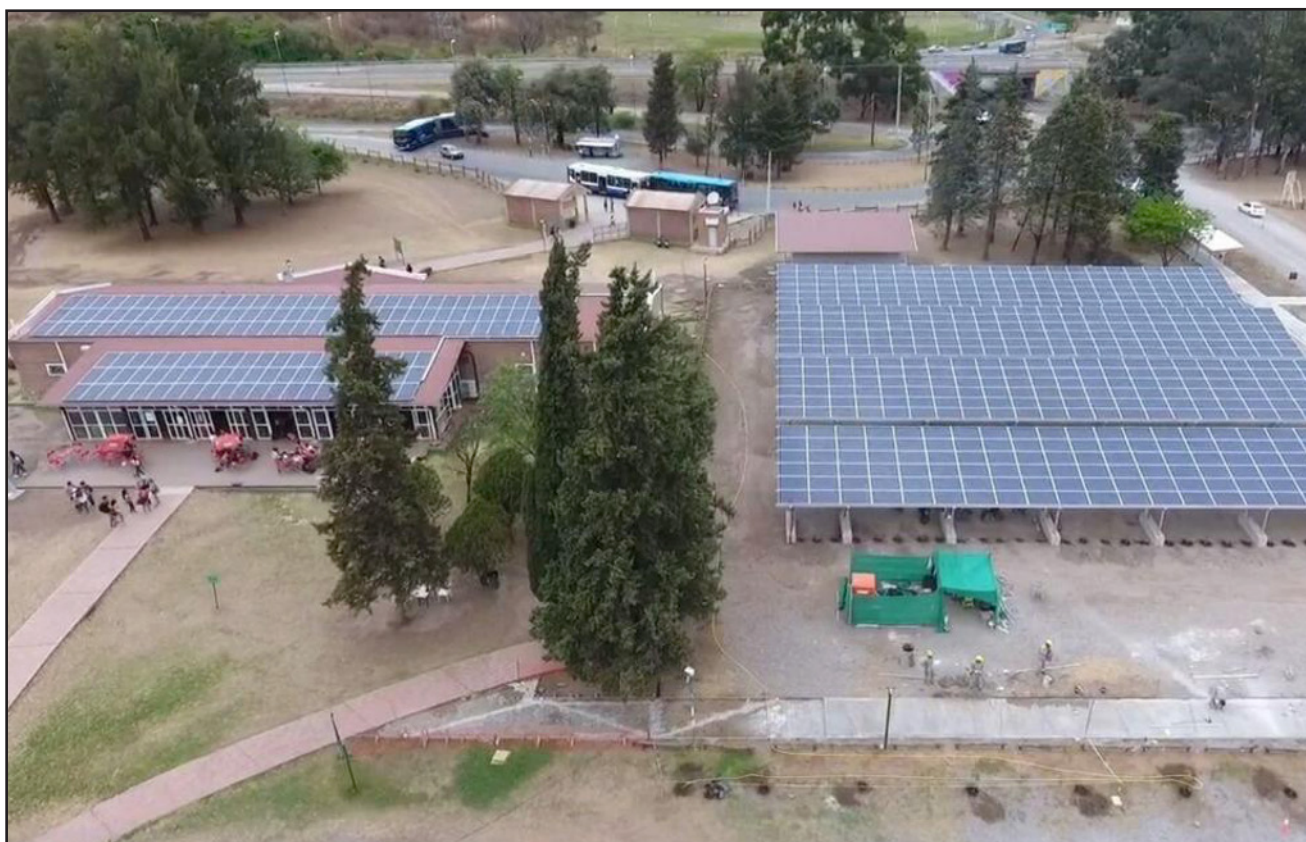
Figura 6: Instalaciones FV en el campus de la UCASAL - Salta. Se destacan sobre la derecha los refugios para estacionamiento con módulos fotovoltaicos integrados a la arquitectura (BIPV), en el cual se reemplazan las cubiertas metálicas habituales.
