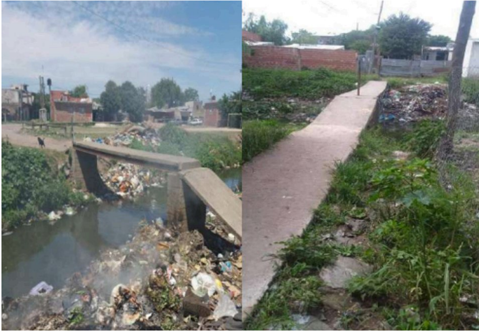
Figura 7. Puentes peatonales que atraviesan el arroyo Las Piedras construidos en el BALP I.
