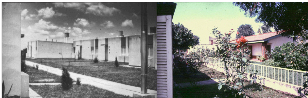
Conjunto de 16 viviendas, recién terminadas... y luego habitadas.
