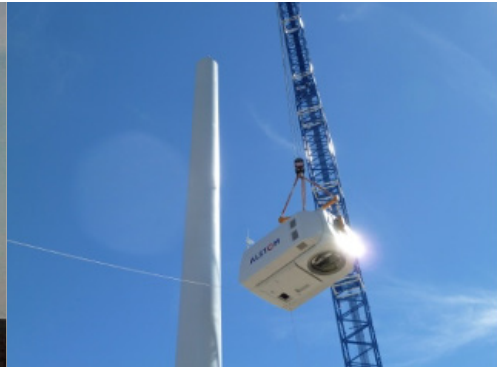
Montaje de aerogenerador en Trelew. Abril 2013. Fte: Toma propia
