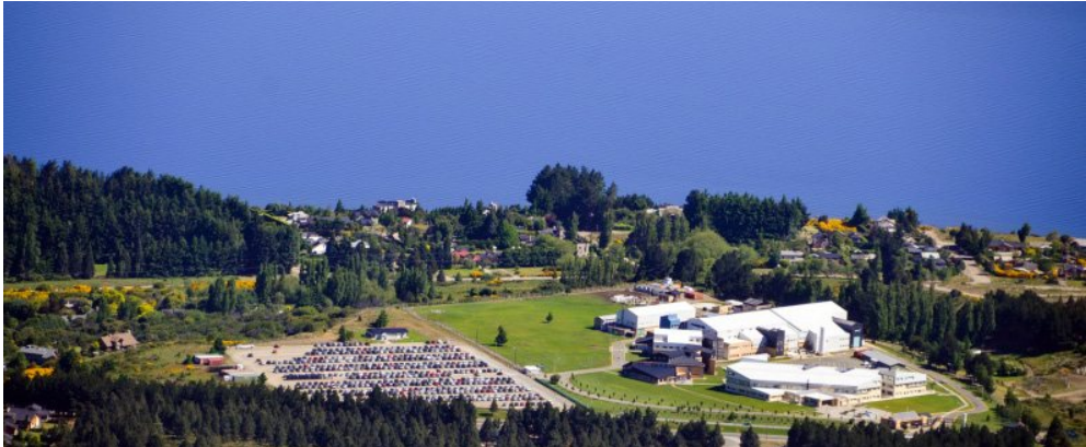
Figura 2. Sede Central de INVAP SC. de Bariloche.
