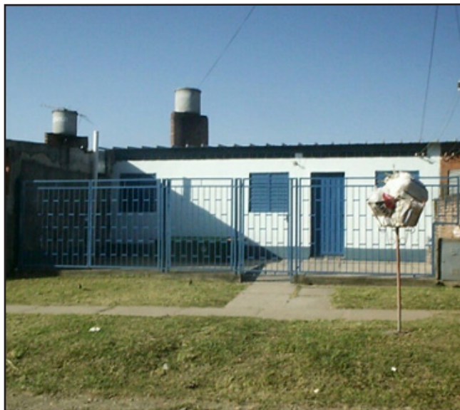
Figura 5. Vivienda original del barrio C.T.O.
