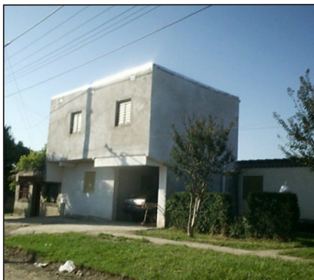
Figura 7. Vivienda con modificaciones importantes.
