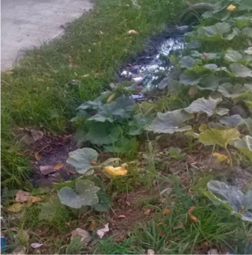
Figura 7. Zanja obturada por vegetación y basura, con agua estancada. Fotografía tomada durante los relevamientos de 2018. Fuente: Capuano y Perez (2019).
