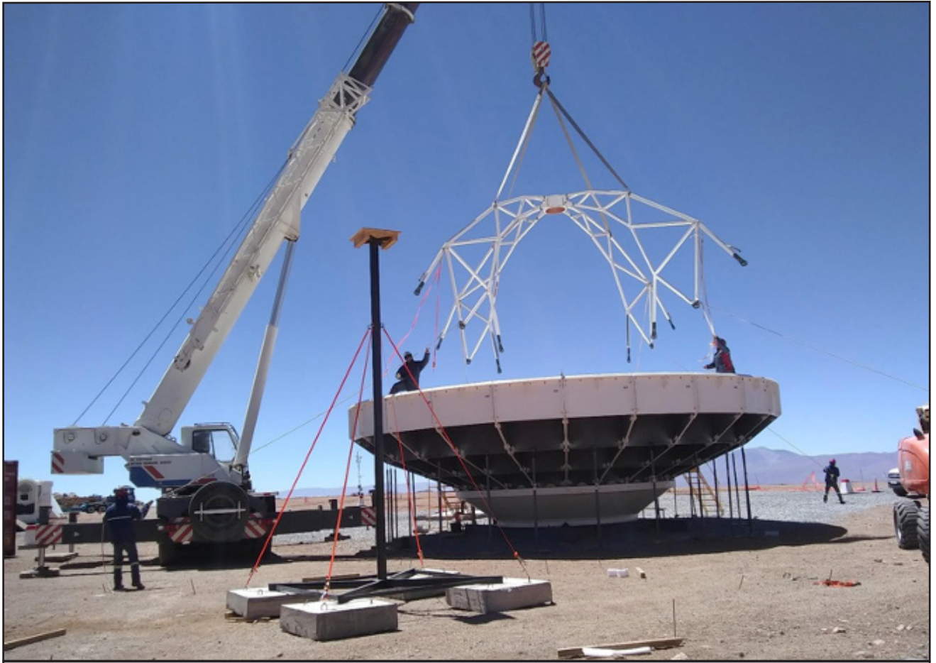
Figura 12. Colocación del quadrapod de la antena.
