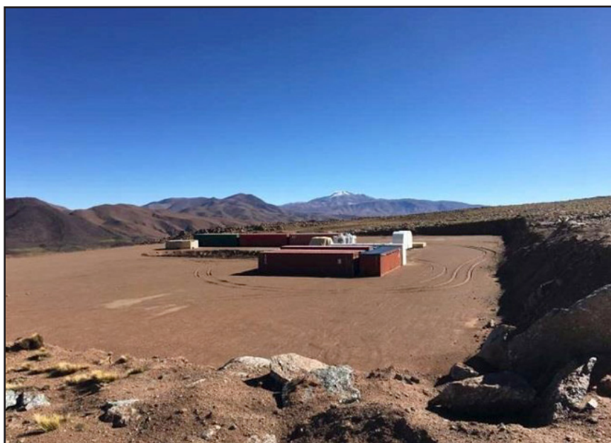
Figura 3. El sitio en Alto Chorrillos, con los componentes de la antena dentro de los containers, antes de su armado.
