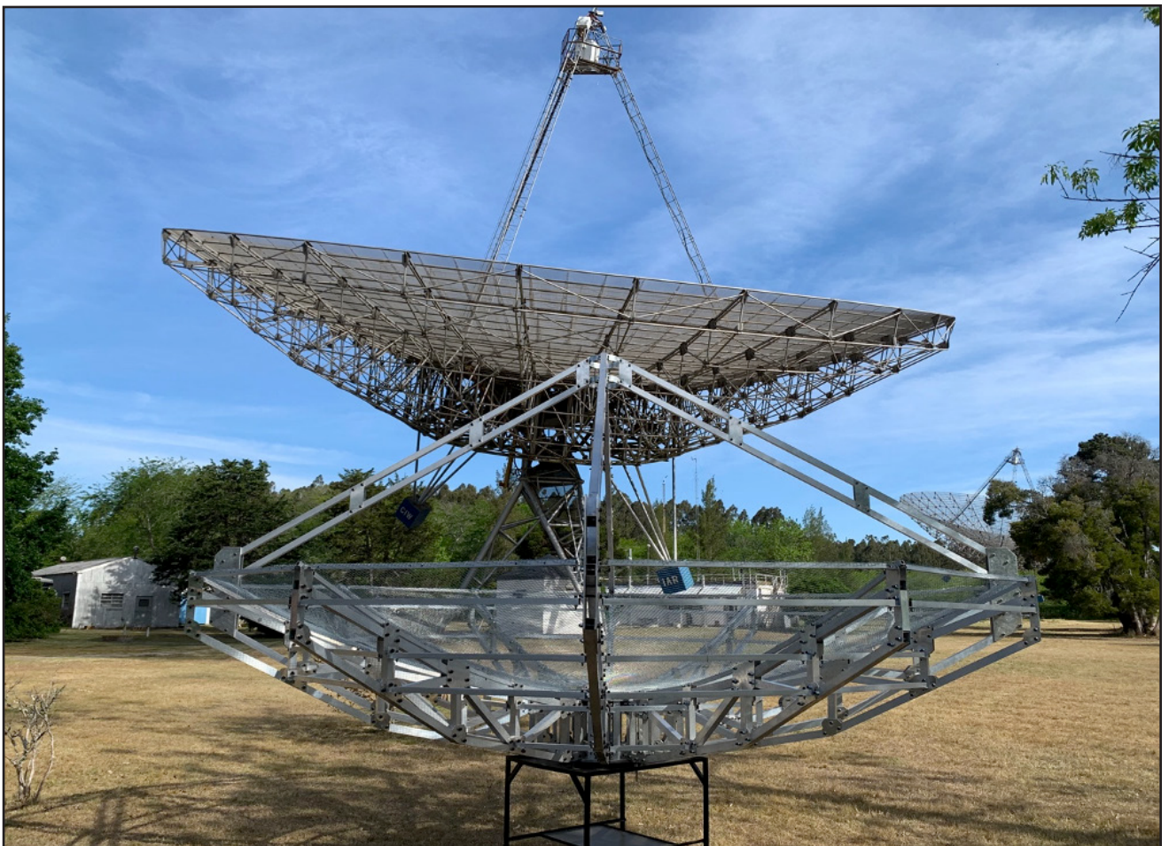
Figura 5. Antena terminada, junto a los dos grandes radiotelescopios del IAR.
