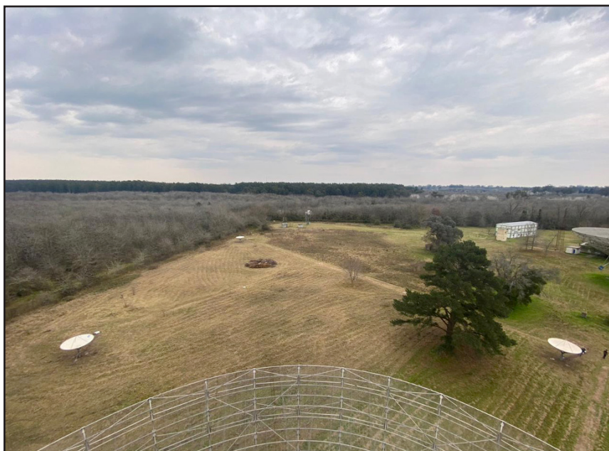
Figura 13. Las tres primeras antenas en su posición en el IAR (agosto 2024).
