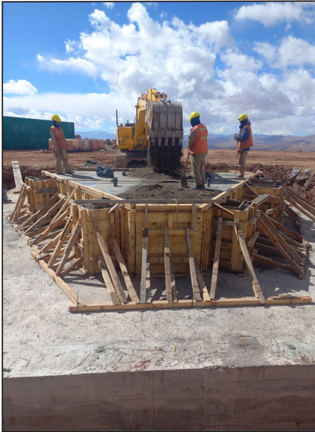
Figura 9. Encofrado final de la fundación de apoyo de la antena.
