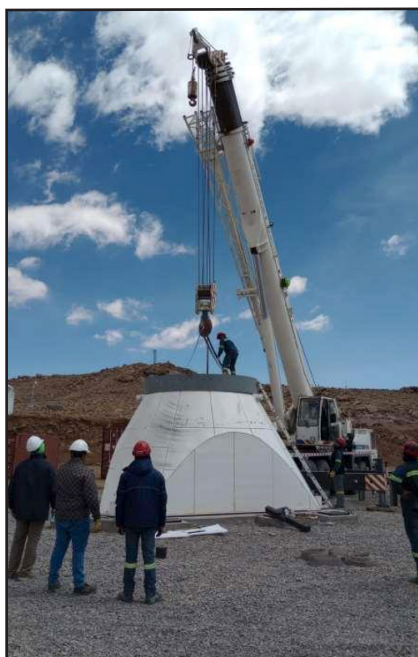
Figura 13. Montaje de la base del pedestal de la antena.
