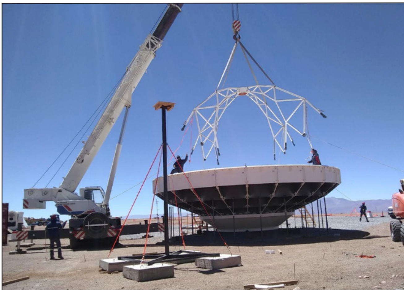
Figura 12. Colocación del quadrapod de la antena.
