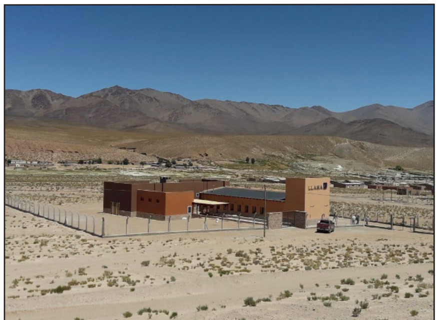
Figura 2. Edificio de LLAMA en San Antonio de los Cobres.
