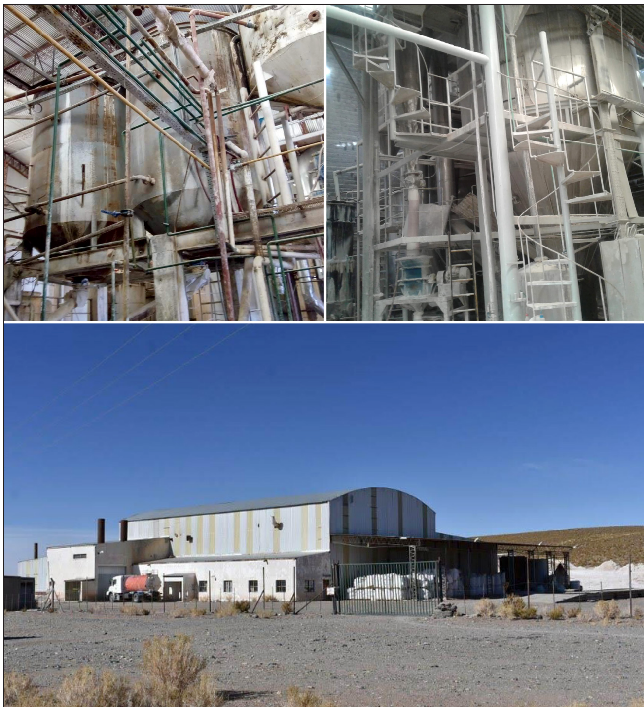
Tres vistas de las instalaciones de AGENOR en San Antonio de los Cobres.
