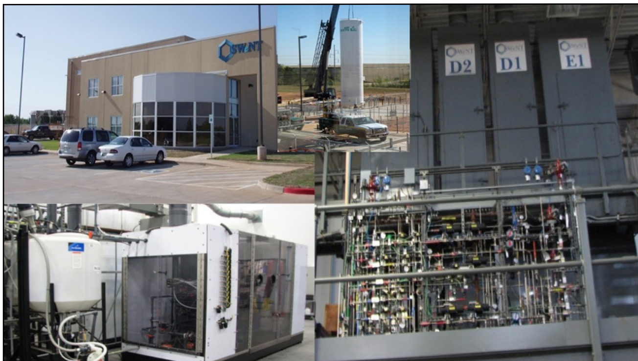
Figura 3. Planta para producción industrial de nanotubos de carbono en Norman, OK. Cuatro reactores catalíticos de lecho fluidizado y planta de purificación
