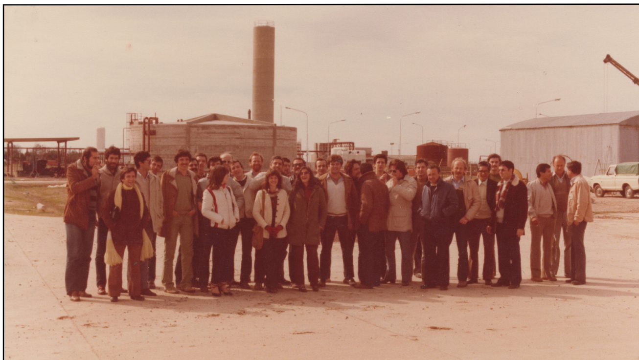
A principio de 1983, una buena parte de los ingenieros y científicos que trabajaron en el proyecto, visitaron la planta en construcción en Atucha.
