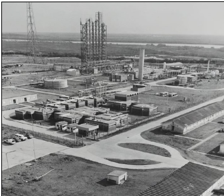
Vista panorámica de la PMEAP. Año 1983. Al frente edificios de administración y talleres. Al fondo área de procesos con las torres de intercambio gas-líquido. La estructura a la izquierda de las torres es la antorcha que se usa para quemar el sulhidrico durante emergencias.
