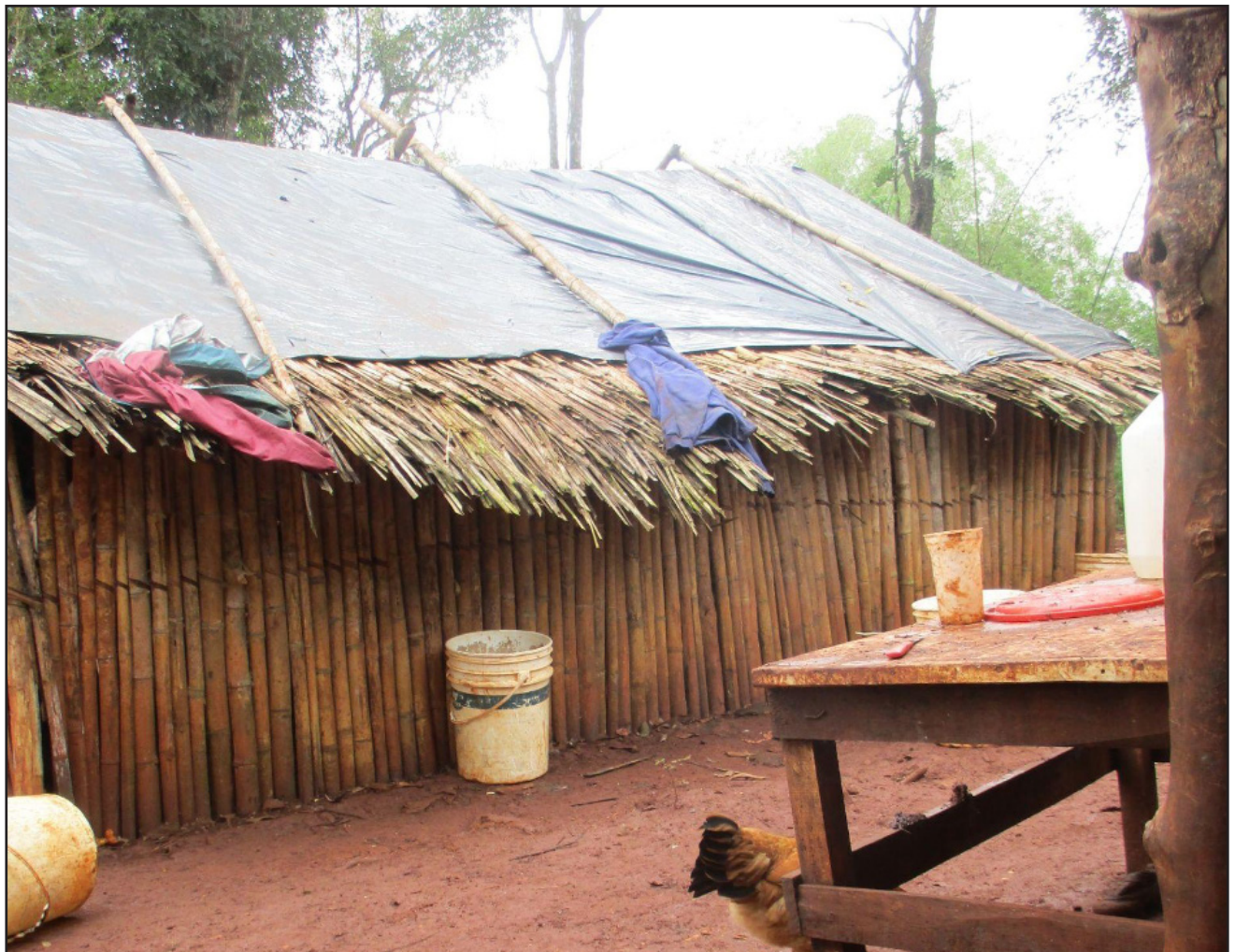
Ilustración 4. Techo reparado. Vivienda, Iguazú 2016. Noelia Enriz.
