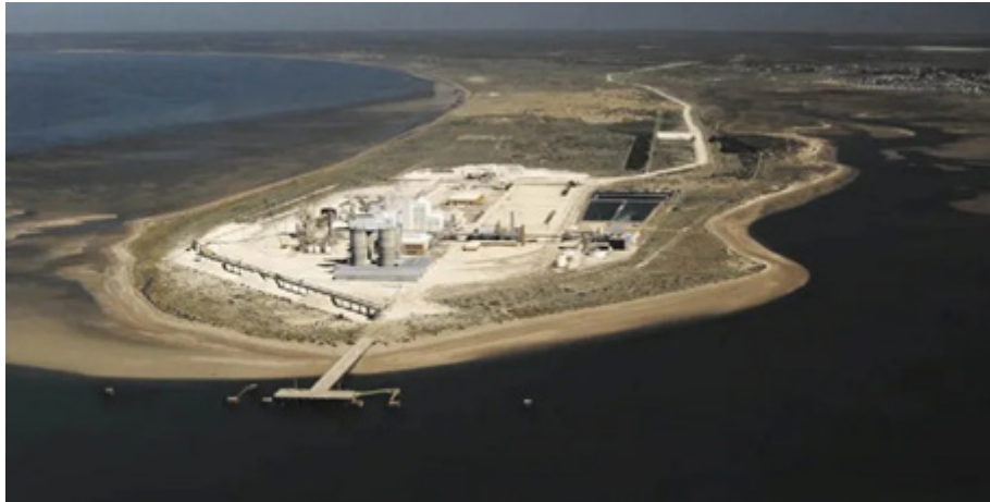
Figura 21. Planta de soda Solvay de la firma Alpat en San Antonio Oeste
