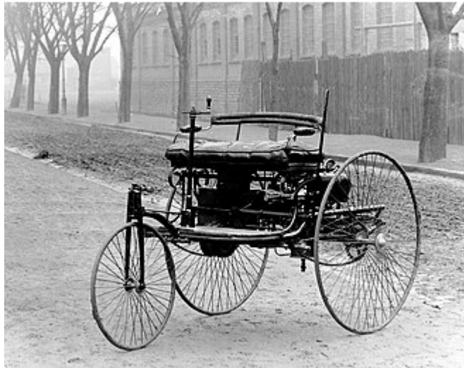
Figura 56. El Benz Patent Motorwagen fabricado por Karl Benz entre 1886 y 1893, primer auto con motor de combustión interna. Fuente: https://commons.wikimedia.org/wiki/File:-1885Benz.jpg
