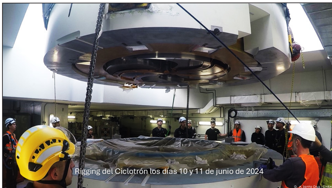
Figura 4. Ingreso del ciclotrón al búnker del CeArP (junio de 2024).
